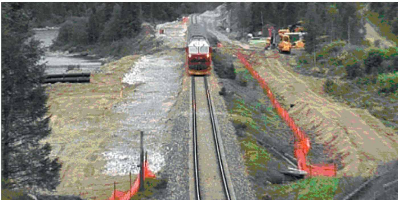
Jernbanelinjen bygger nå et 1000 m langt vekslingsspor ved Eiterstraum/Eiteråga 17 km sør for Mosjøen. Dette og fjernstyringen styrker kapasiteten for godstrafikk på Nordlandsbanen. Foto: EK 20©05.
